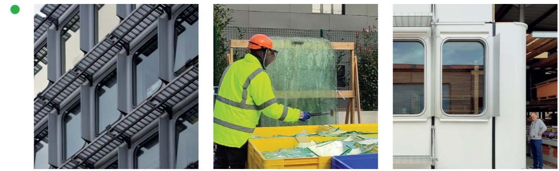
UNESCO Paris, France Patriarche Projet pilote de recyclage de vitrages architecturaux. Les fenêtres ont été démontées puis brisées pour obtenir du verre recyclable (calcin) à son tour recyclé pour créer du verre de haute qualité
