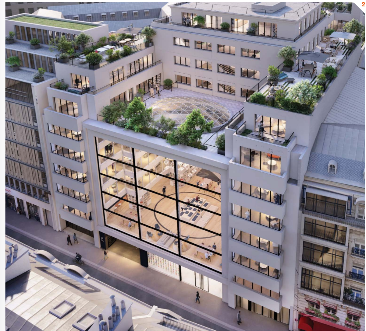
2 Marbeuf PCA Stream Paris, France Réhabilitation et mise en valeur d'un bâtiment prestigieux proche des Champs Elysées, obtenant les certifications suivantes: HQE BD 2016 niveau excellent / LEED niveau gold / WELL niveau gold / label biodiversity
